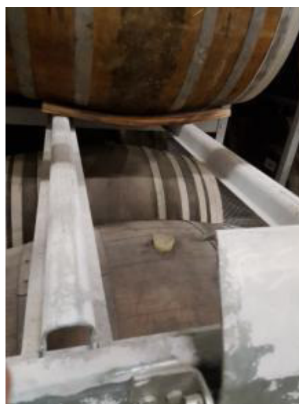
Photo n°6 : détail des longerons longitudinaux
