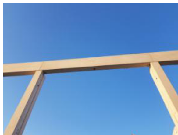
Photo n°4 : liaison poteau poutre haute de rive
