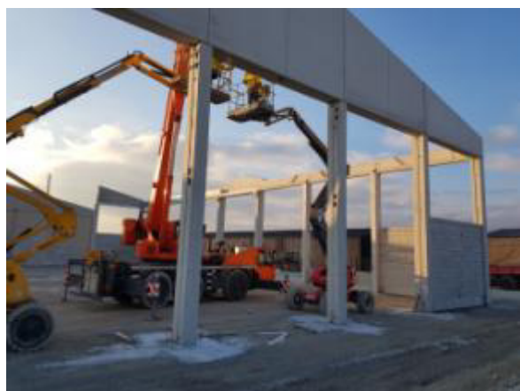
Photo n°1 : montage structure chai 30
