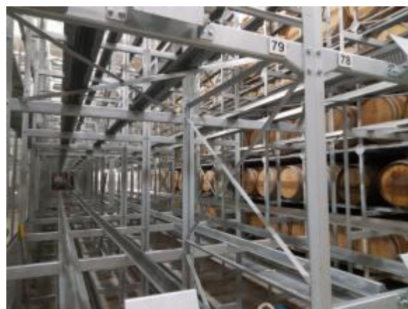
Photo n°2 : structure du rack (2 travées transversales 78 et 79), contreventements longitudinal et horizontal
