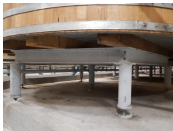
Photo n°2 : support de tonneau. Pas de fixation apparente
