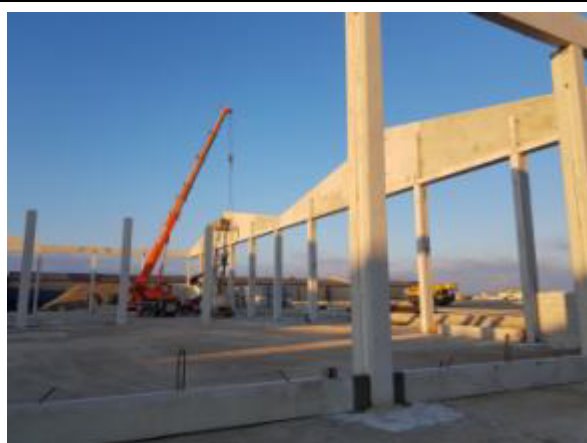
Photo n°5 : liaison poteaux – éléments de fronton
