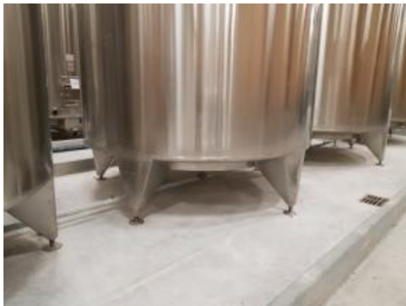
Photo n°3 : base des petites cuves inox
