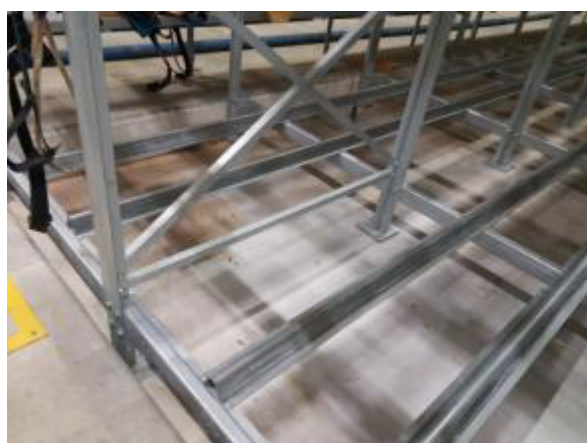
Photo n°3 : vue des appuis au sol, contreventement vertical et longerons
